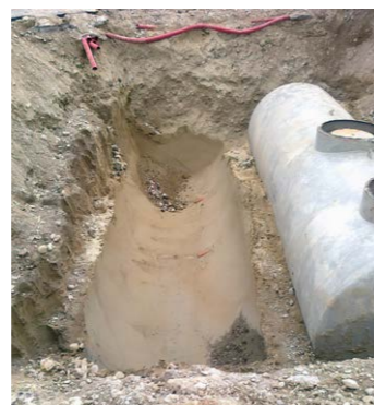
Rimozione serbatoi con procedure che ne consentono il mantenimento di integrità
