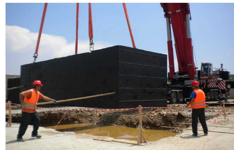
Utilizzo di autogrù di grandi portate per movimentazioni in sicurezza di carichi pesantissimi: cassone in c.a. 70 ton
