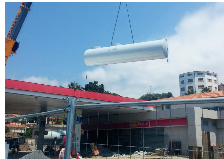
Passaggio del carico sospeso su pensilina e prefabbricato
