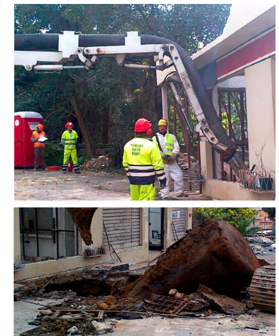
Uso escavatore a risucchio per rimuovere un serbatoio sotto un fabbricato
