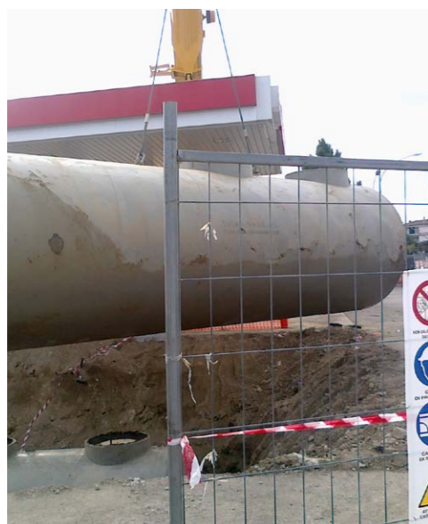
Rimozione serbatoi con procedure che ne consentono il mantenimento di integrità
