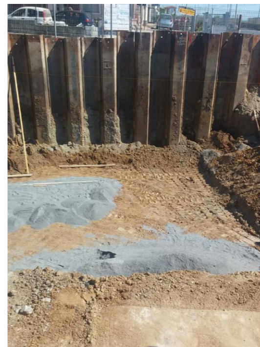
Protezione scavo con palancole
