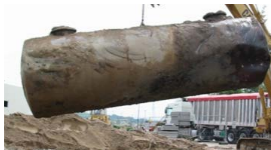
Rimozione serbatoi con procedure che ne consentono il mantenimento di integrità
