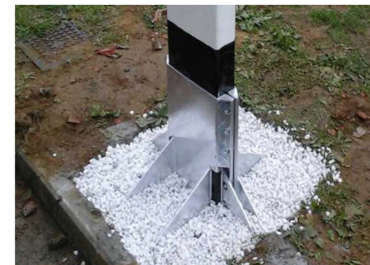
Strutture di rinforzo e protezione da aggressioni saline dei pali esistenti
