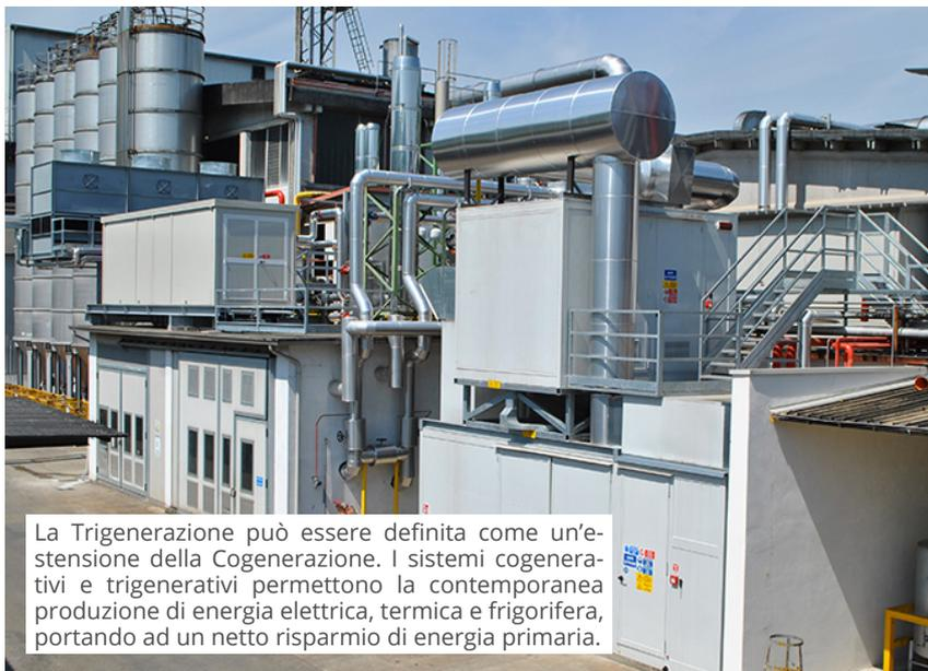
La Trigenerazione può essere definita come un'estensione della Cogenerazione. I sistemi cogenerativi e trigenerativi permettono la contemporanea produzione di energia elettrica, termica e frigorifera, portando ad un netto risparmio di energia primaria.
