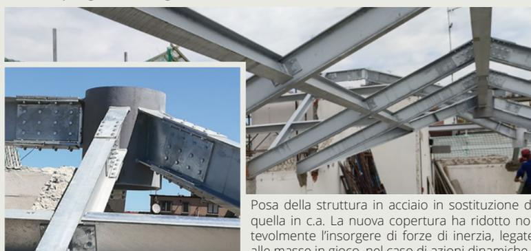
Posa della struttura in acciaio in sostituzione di quella in c.a. La nuova copertura ha ridotto notevolmente l'insorgere di forze di inerzia, legate alle masse in gioco, nel caso di azioni dinamiche
