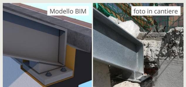
Dal modello BIM alla realizzazione in cantiere: i risultati del calcolo strutturale diventano direttamente cantierabili grazie all'elevata corrispondenza con la realtà esistente e futura.
