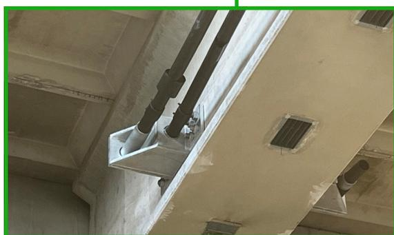
L'applicazione dello sforzo di tensione, trasmesso alle travi per mezzo dei cavi installati, ha consentito un recupero parziale della deformata. Nella nuova condizione la freccia al di sotto della trave è diminuita in media del 35%, questo ha consentito una luce variabile tra i 5 e i 7 cm tra l'intradosso della trave e la sommità del carrello. Pertanto, la funzionalità del carroponete è stata completamente ripristinata.
