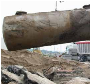
Rimozione serbatoi con procedure che ne consentono il mantenimento di integrità
